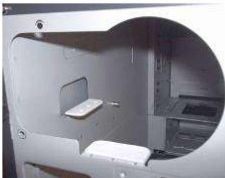
Рисунок 264 Мягкие прокладки на лапках под блоком питания
